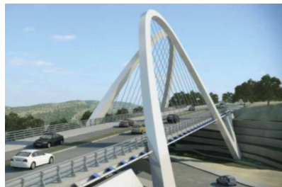
תמונה 2: חלופת קשתות מדורגת נטויות פנימה
