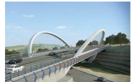
תמונה 1: חלופת קשתות נטויה החוצה חלופה נבחרת
