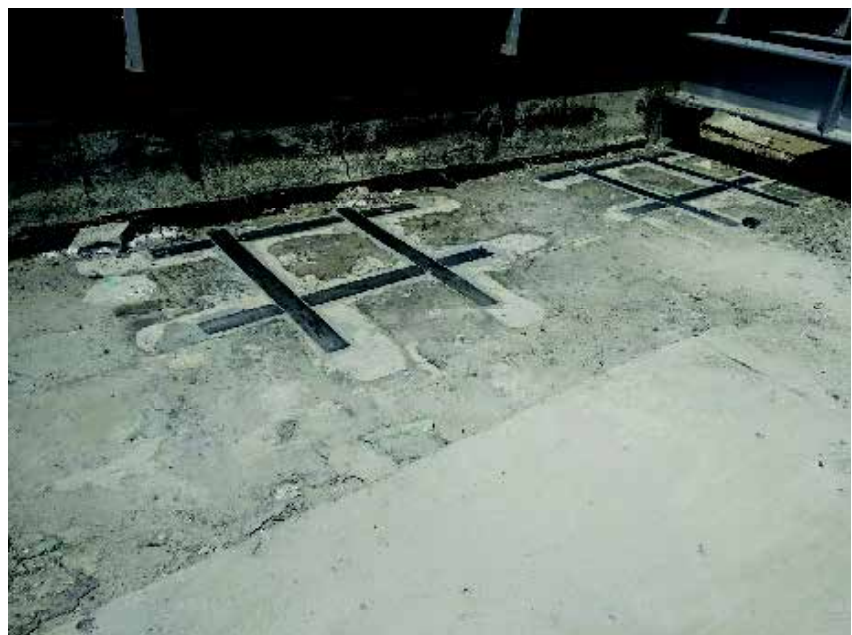
חיזוק פלטות טרומיות קודם הניסור באמצעות רצועות למינט
