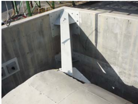
איור 4: חיזוקים בעזרת חבקים למגדל פלדה נושא חומ"ס שנמצא באזור רווי מימן בסכנת התלקחות.
