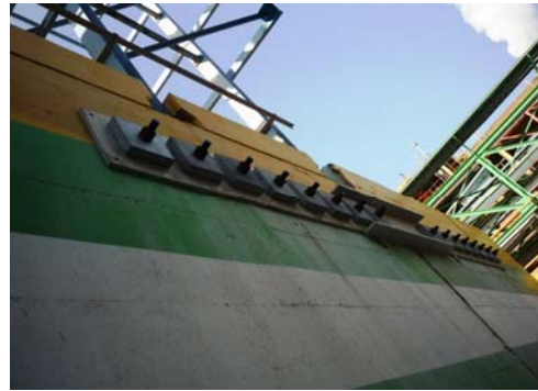
איור 4: חיזוקים בעזרת חבקים למגדל פלדה נושא חומ"ס שנמצא באזור רווי מימן בסכנת התלקחות.
