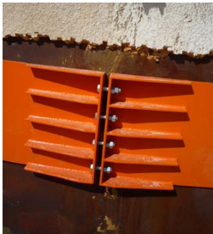
איור 3: חבק פלדה דרוך ומעוגן לבסיס בטון שיושם באזור בו לא ניתן לטפל במיכל החומ"ס עצמו.
