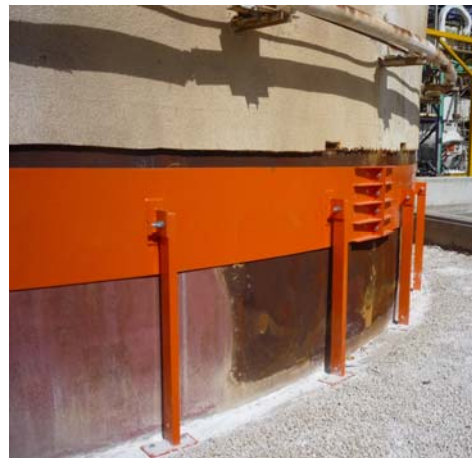
איור 3: חבק פלדה דרוך ומעוגן לבסיס בטון שיושם באזור בו לא ניתן לטפל במיכל החומ"ס עצמו.
