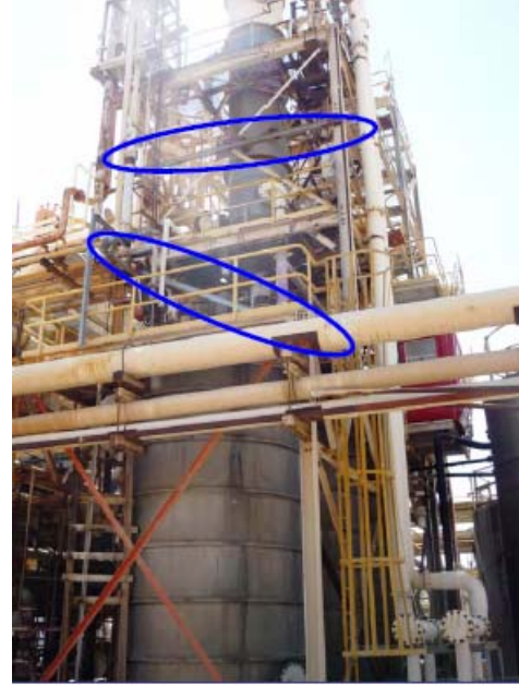
איור 4: חיזוקים בעזרת חבקים למגדל פלדה נושא חומ"ס שנמצא באזור רווי מימן בסכנת התלקחות.
